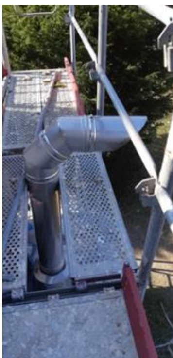
Sortie de la toiture de la sacristie, la cheminée en inox du chauffage gaz....
