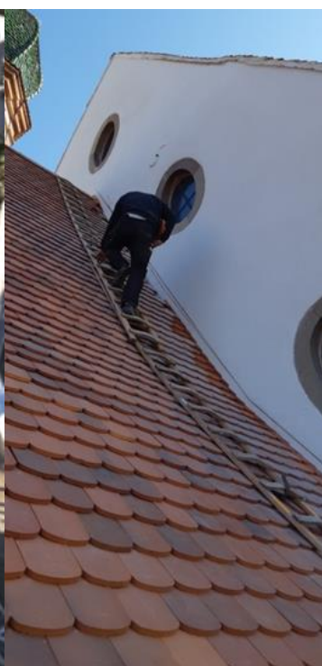
Toiture chœur contre pignon nord
