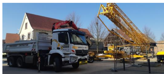
Grue préparée pour le chargement...
