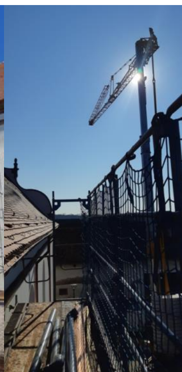
Toiture nef, grue et filins de protection
